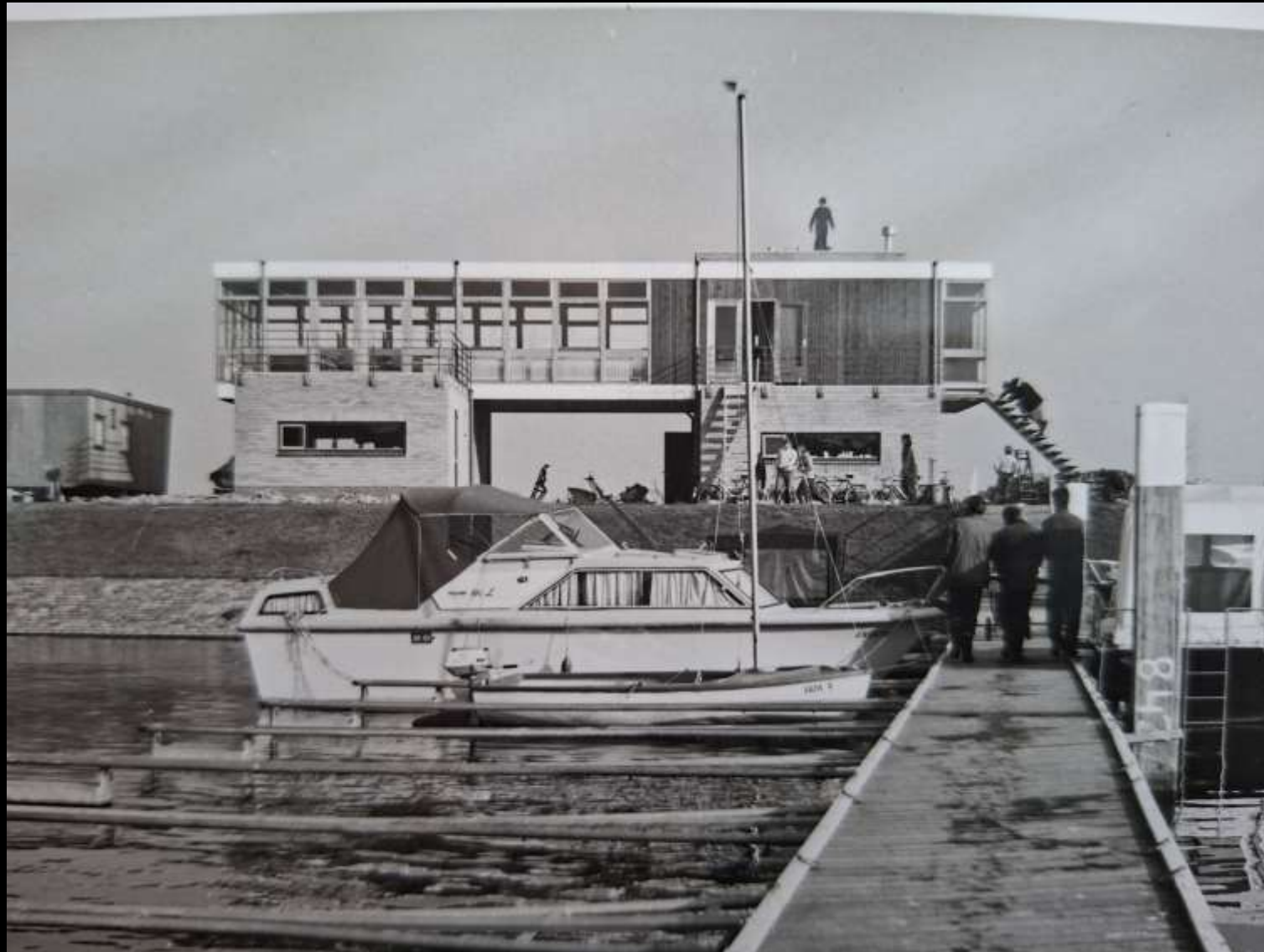
Clubschip 4 in aanbouw vanaf de steiger
